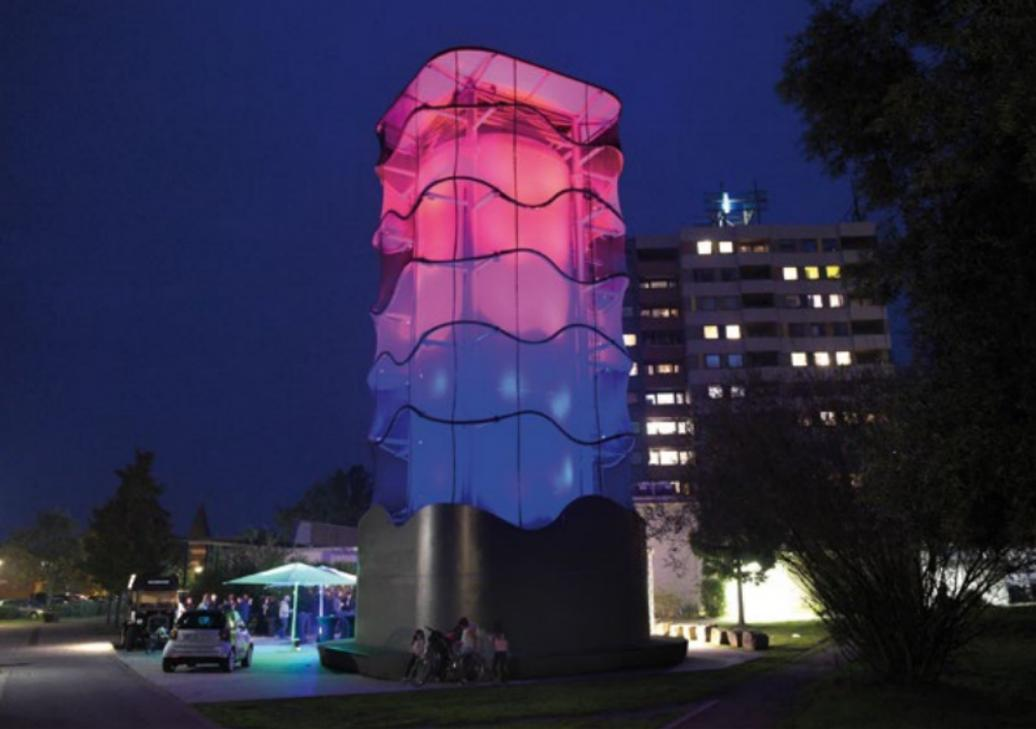
Sichtbare Erfolge: Der neue Großwärmespeicher bildet das Herzstück des Nahwärmenetzes in Hildesheim Drispensstedt. Eine Hülle aus gewebtem Kunststoff lässt ihn nachts in unterschiedlichen Farben leuchten
